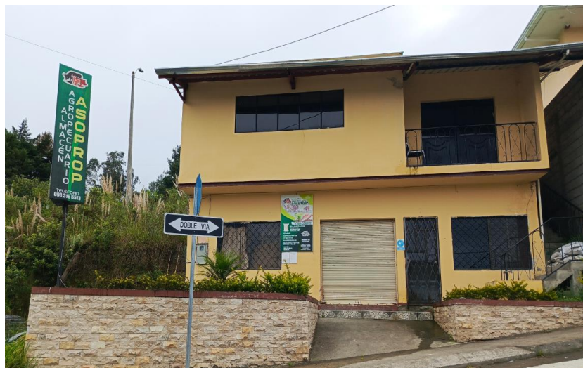
Ilustración 74: Almacén Agropecuario ASOPROP
